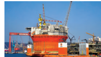
2015 02 세계 최대 원통형 골리앗 FPSO 출항
